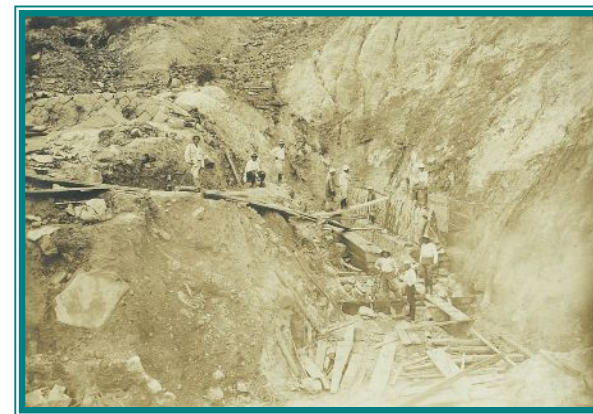
大涌谷開発の作業風景(昭和7年頃)
