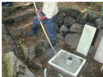
払い棒を掃除口より押し込む
