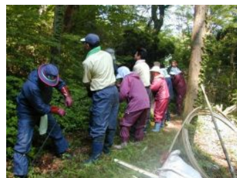
上流側と下流側の二手に別れ、人力でワイヤロープを交互に引っ張り、パイプ内のスケールを削り落とす
