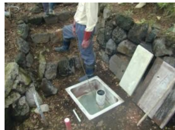
払い棒の端に、ワイヤロープを縛り、パイプの中へ通す
