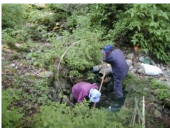
次の掃除口で送られて来た払い棒を引っ張り出し、更に下流のパイプへ押し込む
