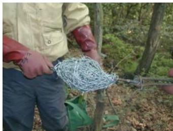
ワイヤロープの中心に有刺鉄線を巻き付けた掃除道具を結び付け、パイプの中へ引き込む
